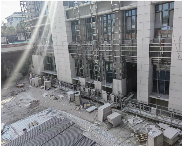
三、羽毛球馆墙面玻镁板安装
