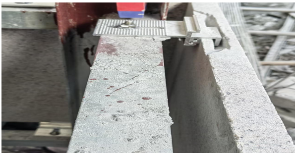
五、石材幕墙角码节点
