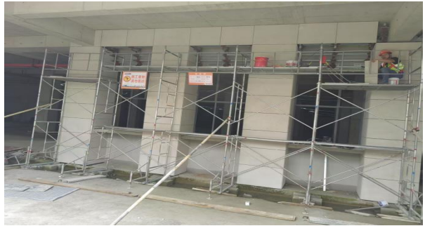
二、地下室外墙石材安装
