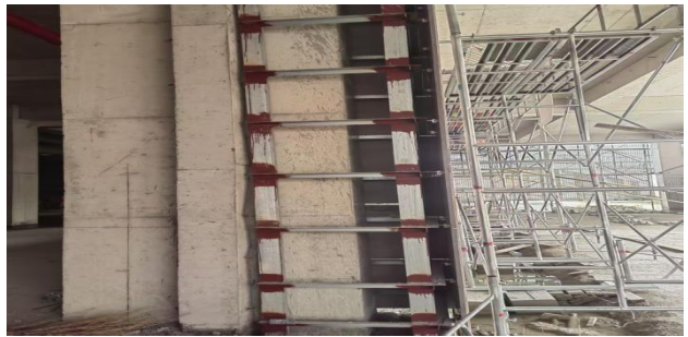
四、大型履带吊SANY (SCC5500A) 拆装移至南边
