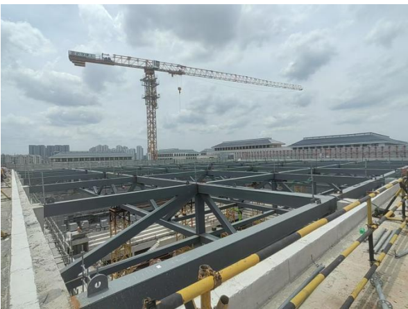
五、屋面桁架吊装完成
