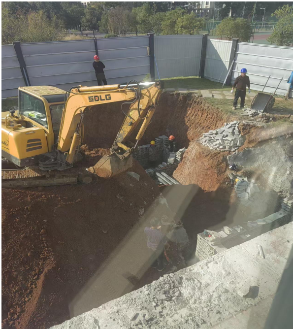
五、室外电缆井砌筑
