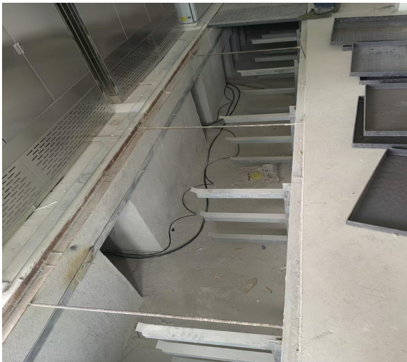
五、二层墙面铝单板安装
