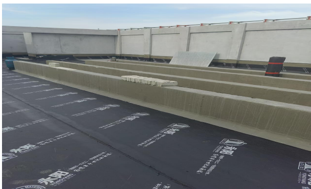
四、屋面卷材防水泛水附加层及涂膜防水
