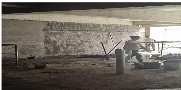
二、内墙面抹灰及做灰饼冲筋
