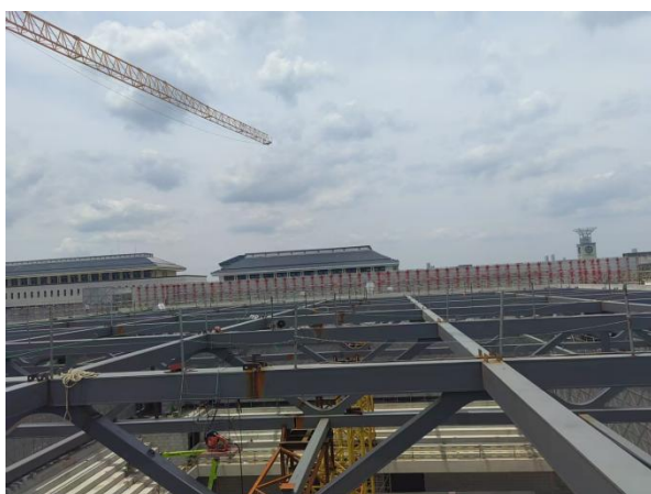
五、大型吊车屋面桁架吊装完成
