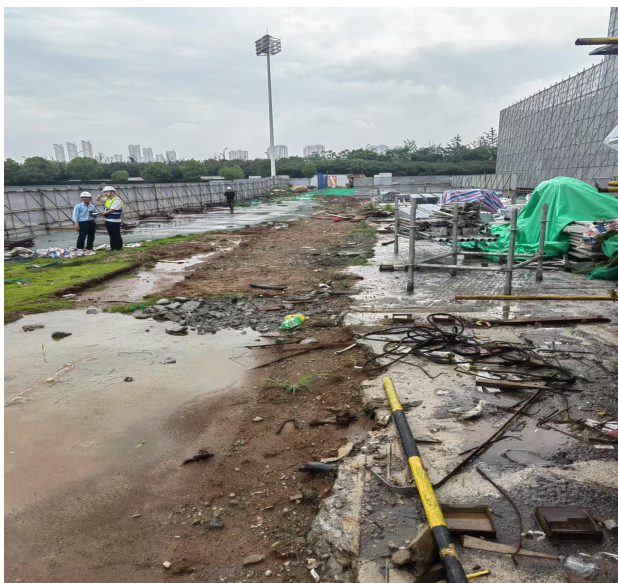
四、临时围挡工程量复核
