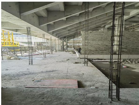
五、二层构造柱钢筋绑扎、植筋
