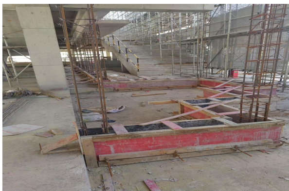
五、二层构造柱钢筋绑扎、植筋
